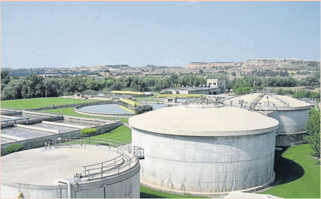
Planta de depuración de agua de Aqualia en la ciudad de Lleida
