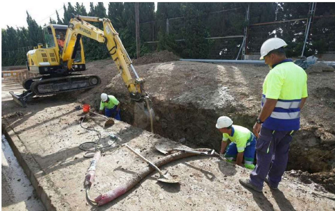
La reparación de una avería por parte de Emalgesa.
